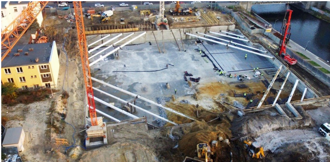
Aktualnie firma Alstal prowadzi prace przy fundamentach nowego basenu krytego.
