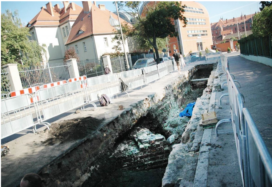
W 2017 roku w trakcie prac archeologicznych odkryto ruiny bydgoskiego zamku.
