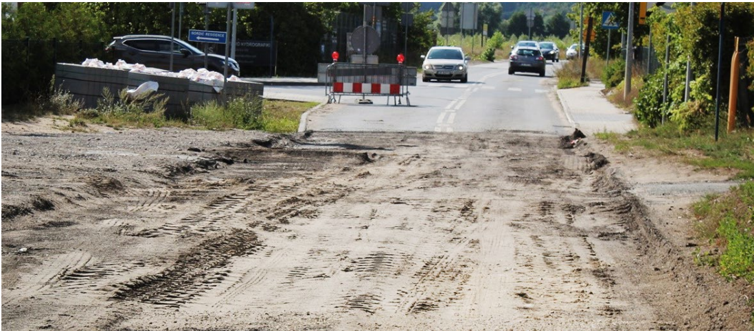
Drogowcy planują wyremontować kolejny fragment ulicy Pod Skarpą. Nie ukrywają jednak, że ze względu na kwestię własności gruntów inwestycja może ulec opóźnieniu.
