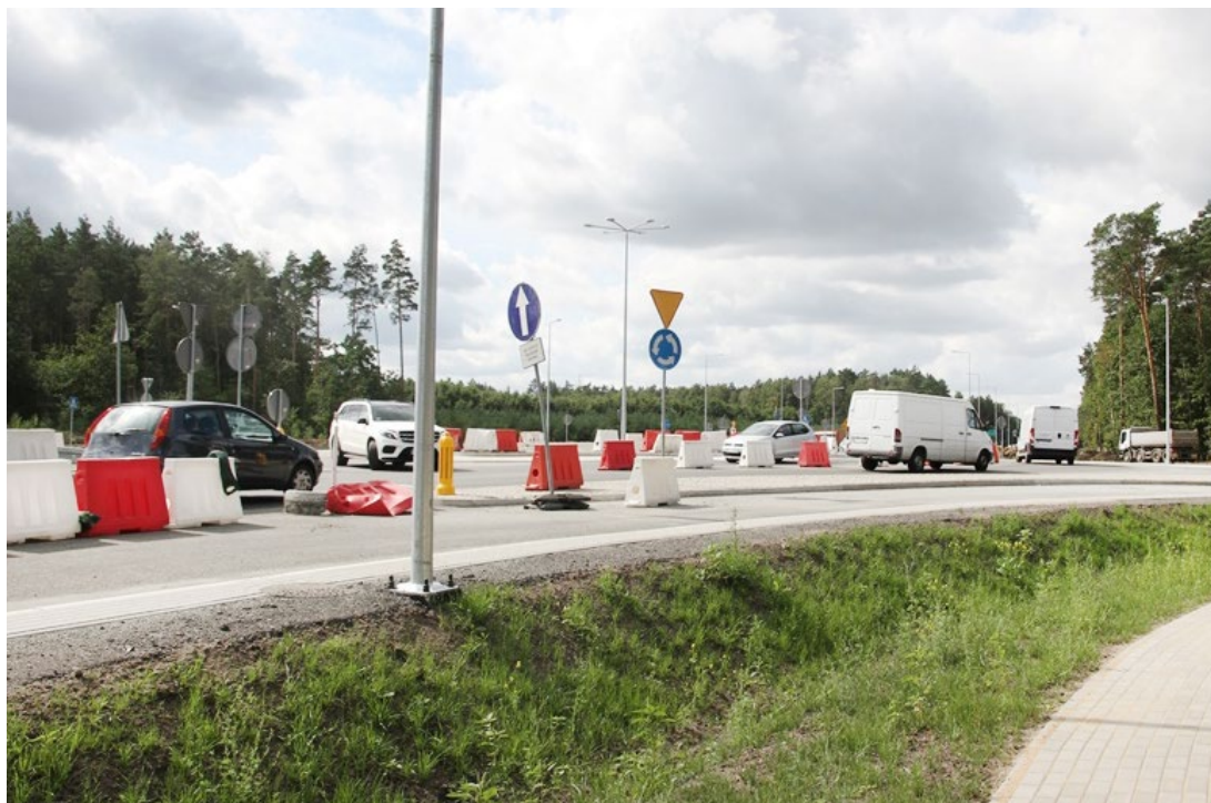
Od końca sierpnia kierowcy mogą się poruszać po nowopowstałym rondzie turbinowym. Droga przy Szubińskiej w godzinach nocnych w ogóle nie jest oświetlona.
