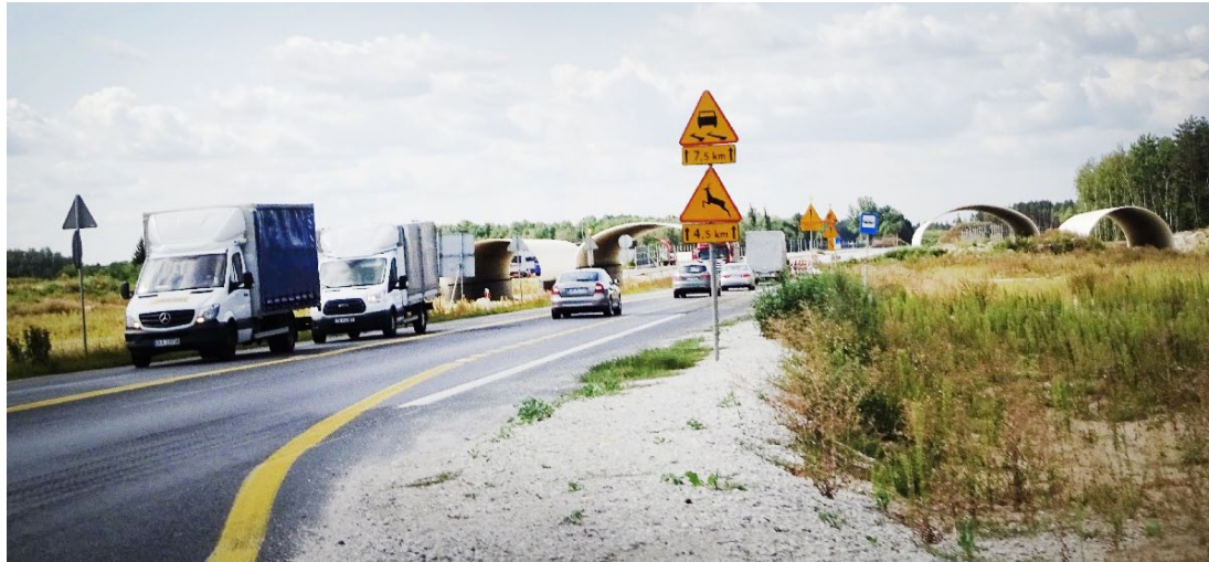
Droga S5 ma poprawić komfort podróży przez województwo kujawsko-pomorskie. Mieszkańcy Lisiego Ogona przypominają jednak, że należy pamiętać również o ruchu lokalnym w rejonie powstającej trasy.
